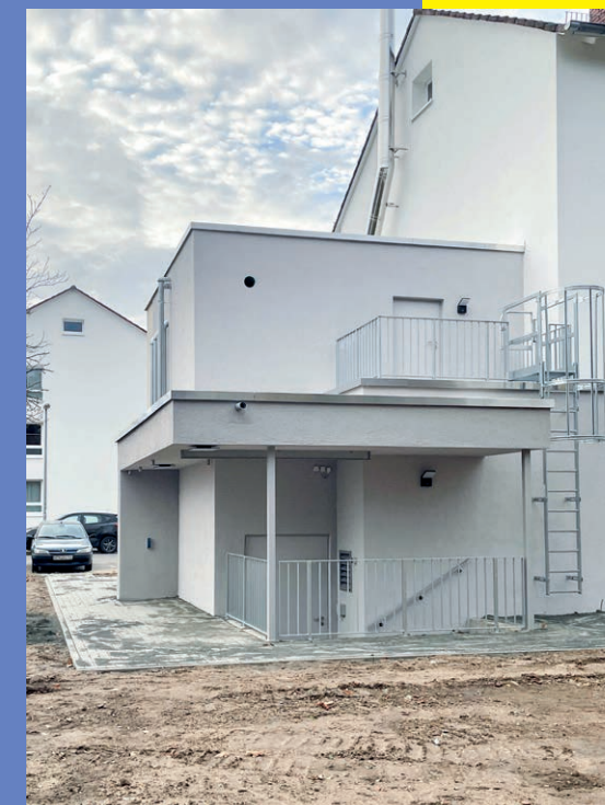
DIE NEUE BIOMASSE-HEIZZENTRALE
