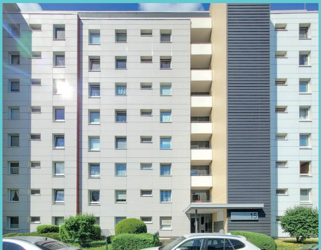
TREPPENHAUS VON AUSSEN VOR DER RENOVIERUNG
